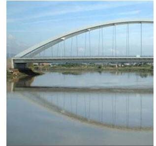
River Usk Bridge
