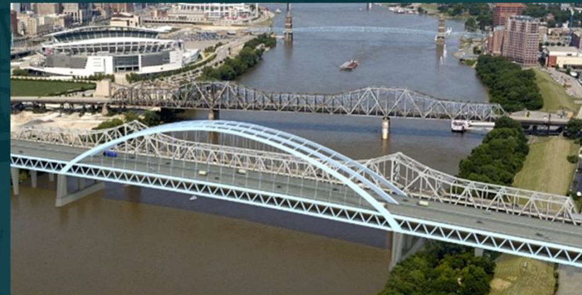
Brent Spence Bridge Project (ODOT & KYTC)
