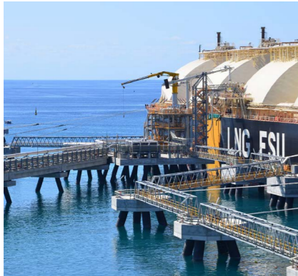
Electrogas Malta LNG
